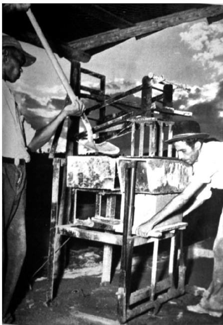
Foto 11. La Máquina CINVA-RAM para la construcción de bloques de arena y cemento se difundió por todo el mundo como una alternativa técnica para los procesos de autoconstrucción de las comunidades.
